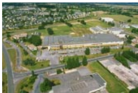
Usine de Segré (Maine-et-Loire) ISO 9001
